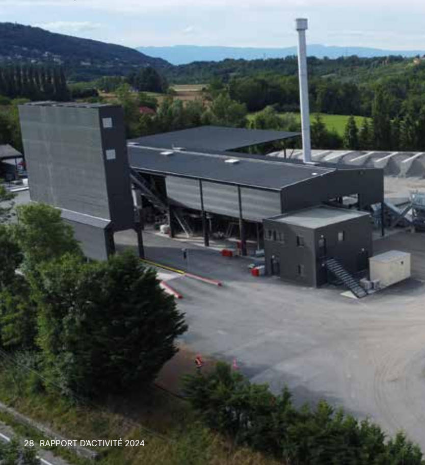
TSX23 INCITY, usine d'enrobés – Ermont
