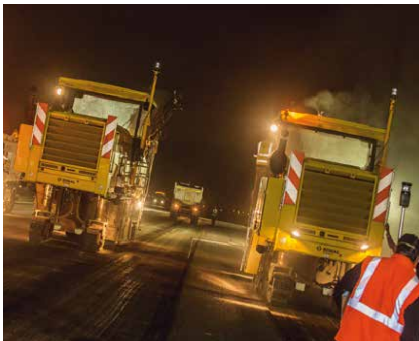
-Photo 3- Réhabilitation des pistes de l'aéroport international de Maputo, au Mozambique.
