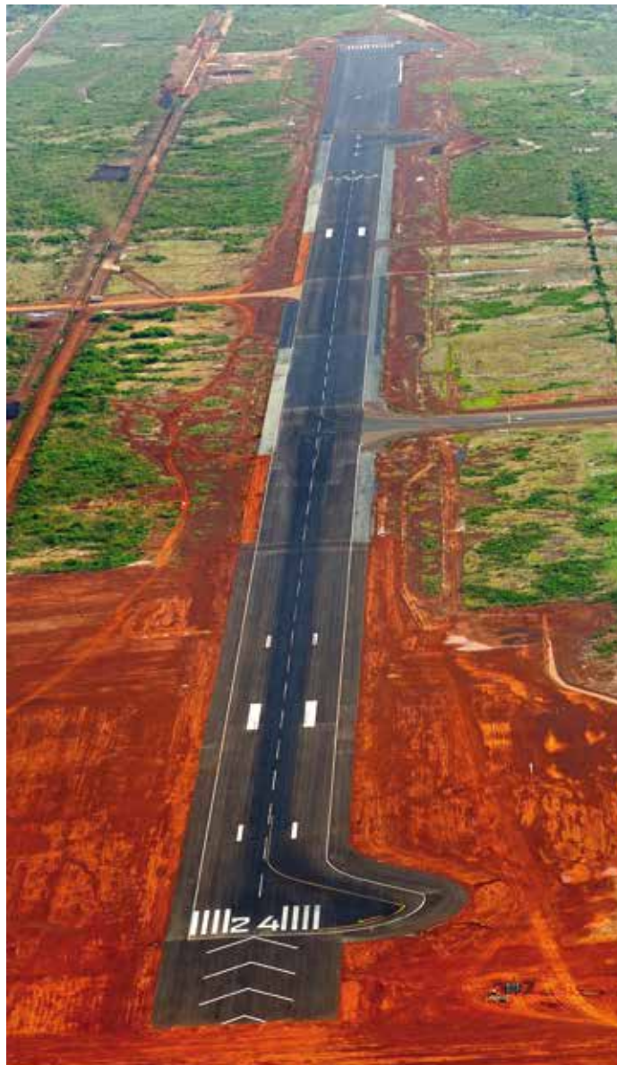
-Photo 4- Raquettes de retournement provisoires sur l'aéroport international de Bamako, au Mali.
